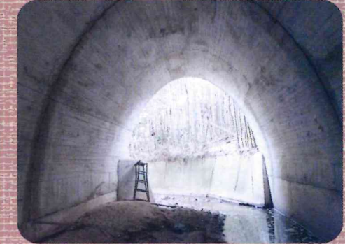
熊取町 アーチ橋内部
