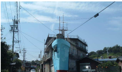
17.戦艦型住居 地区 小鈴谷 ここを通ると誰もがびっくり。戦艦の形をした建物です。
