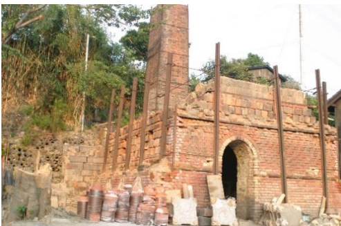
1.遺跡風窯跡 地区 北条 家の改築で、遺跡風煉瓦造りの窯が露呈した。全景が見えるとすばらしい。
