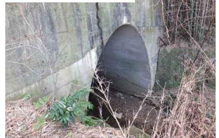
紀泉鉄道アーチ橋跡
